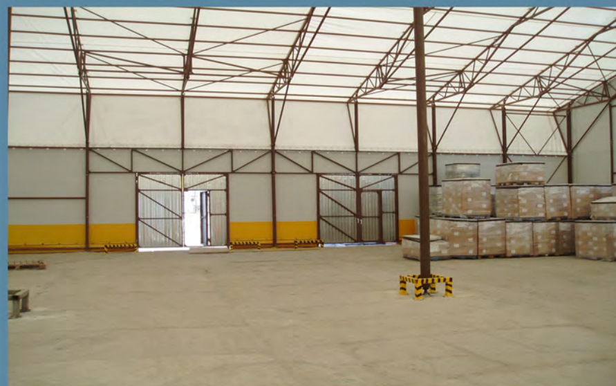
Тентовый склад, размеры 24 x 36 x 6 м, “Лакра-синтез”, п. Ст. Куловка, 2007 г.
