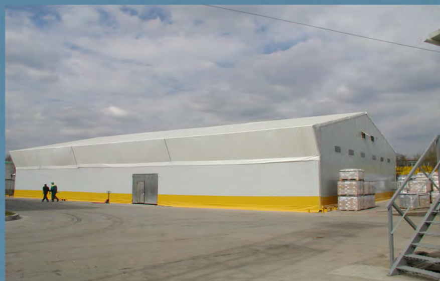
Тентовый склад, размеры 24 x 36 x 6 м, “Лакра-синтез”, п. Ст. Куловка, 2007 г.
