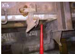
Поджатие центрального ребра жесткости люка для проведения сварочных работ
