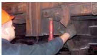
Выправка угла люка и закрытие замка
