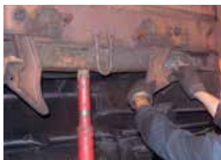
Поджатие люка и вставка уравнильных прокладок
